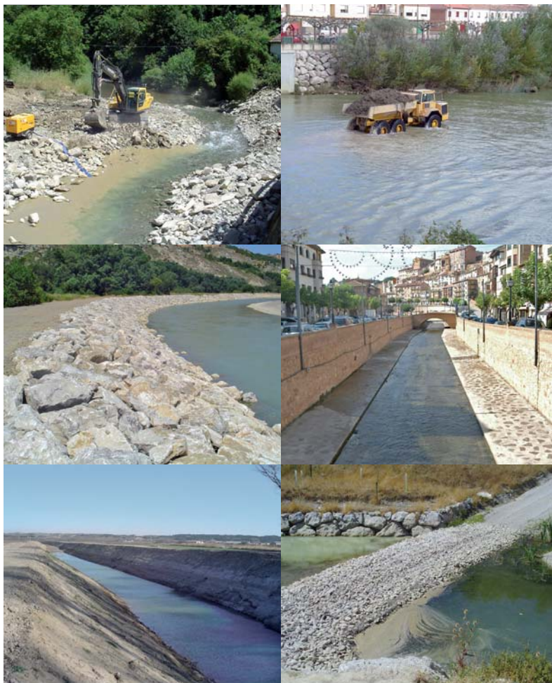
En las fotos superiores, excavadora y camión trabajando en sendos cauces. En las dos imágenes intermedias, escollera y río Queiles a su paso por Tarazona. En las dos inferiores, limpieza de cauce y vado.
