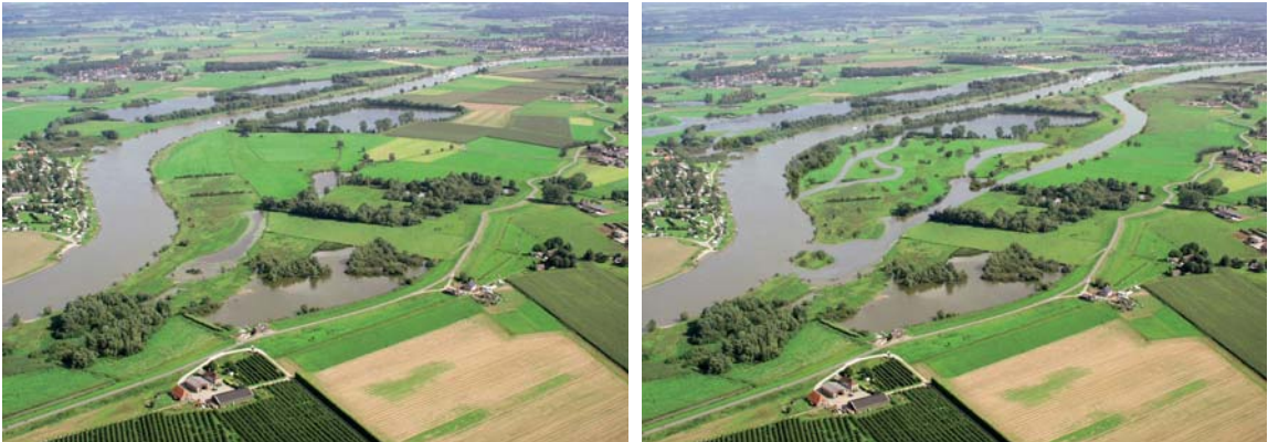
Ejemplo del proyecto "Room for Rivers" en la cuenca del Rin a su paso por Fortmond, Holanda. (Fuente: Matthijs Logtenberg)
